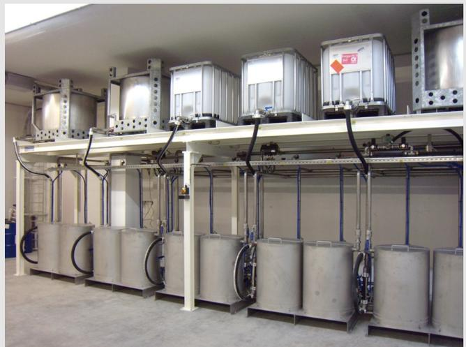
タンクと交換可能なIBCコンテナを設置したタンクパークの例。
